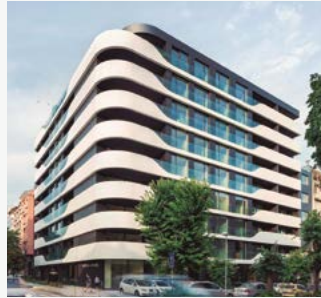
Varna Wave Building. Beboelsesbygning. Varna, Bulgary. Aquarea og Aquarea Smart Cloud.
